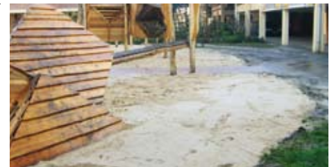
Speeltoestel Kasbah na de afgraving
